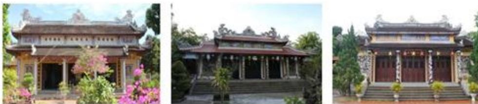
Hình 8. Mái hai lớp của nhà chính điện.
